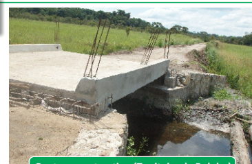
Pont en construction (Territoire de Bolobo)
